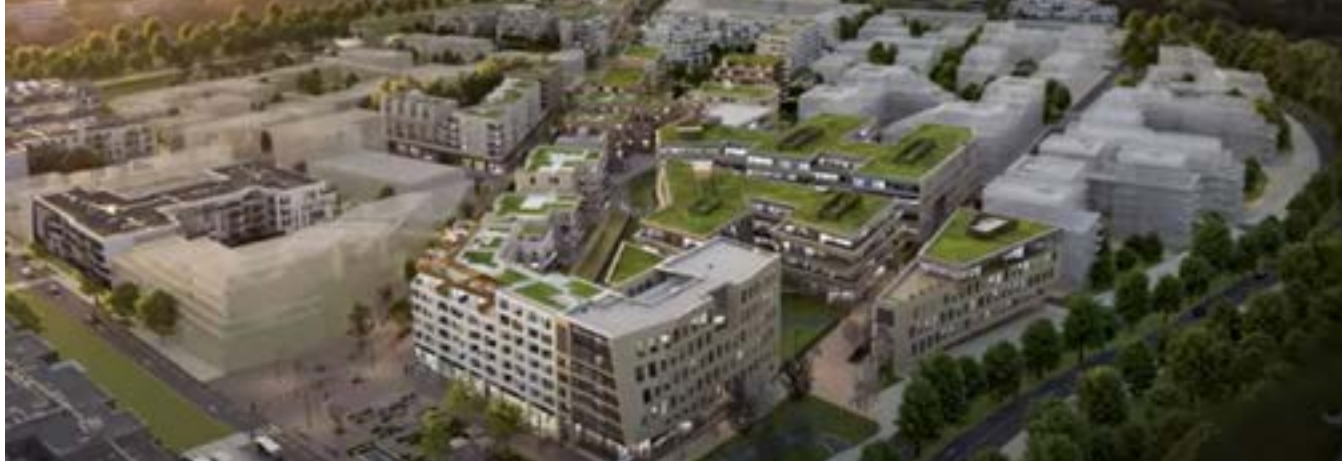
Rue Commerçante à Chatenay-Malabry
